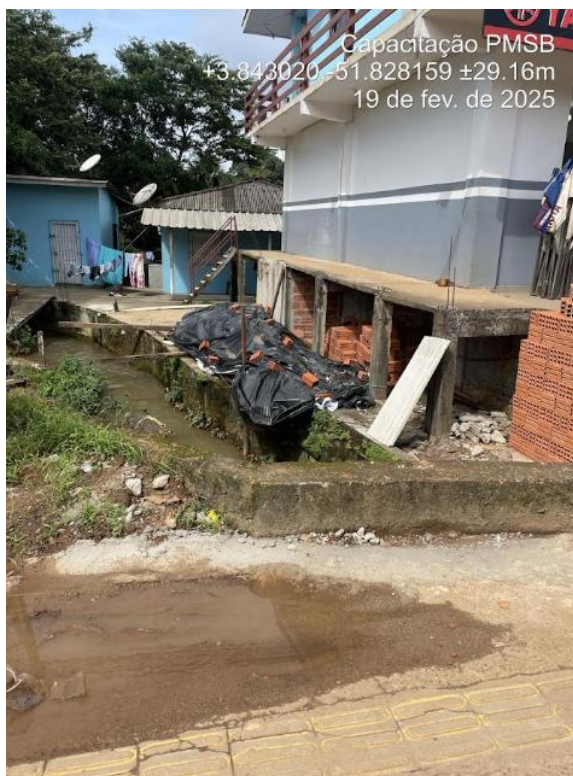
e) Travessia de Rua em galeria (parte final da BR-156, dentro do perímetro urbano).
