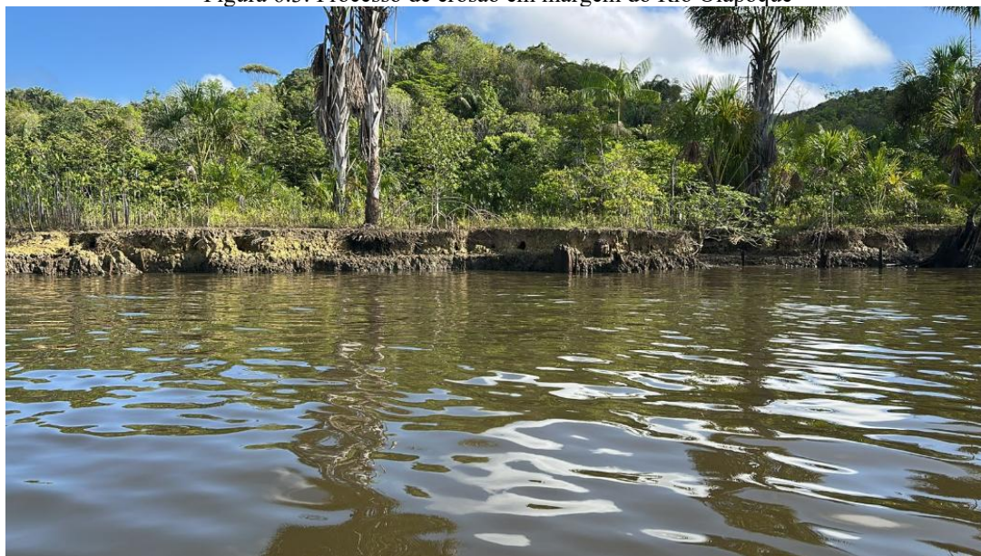
Figura 6.3: Processo de erosão em margem do Rio Oiapoque
