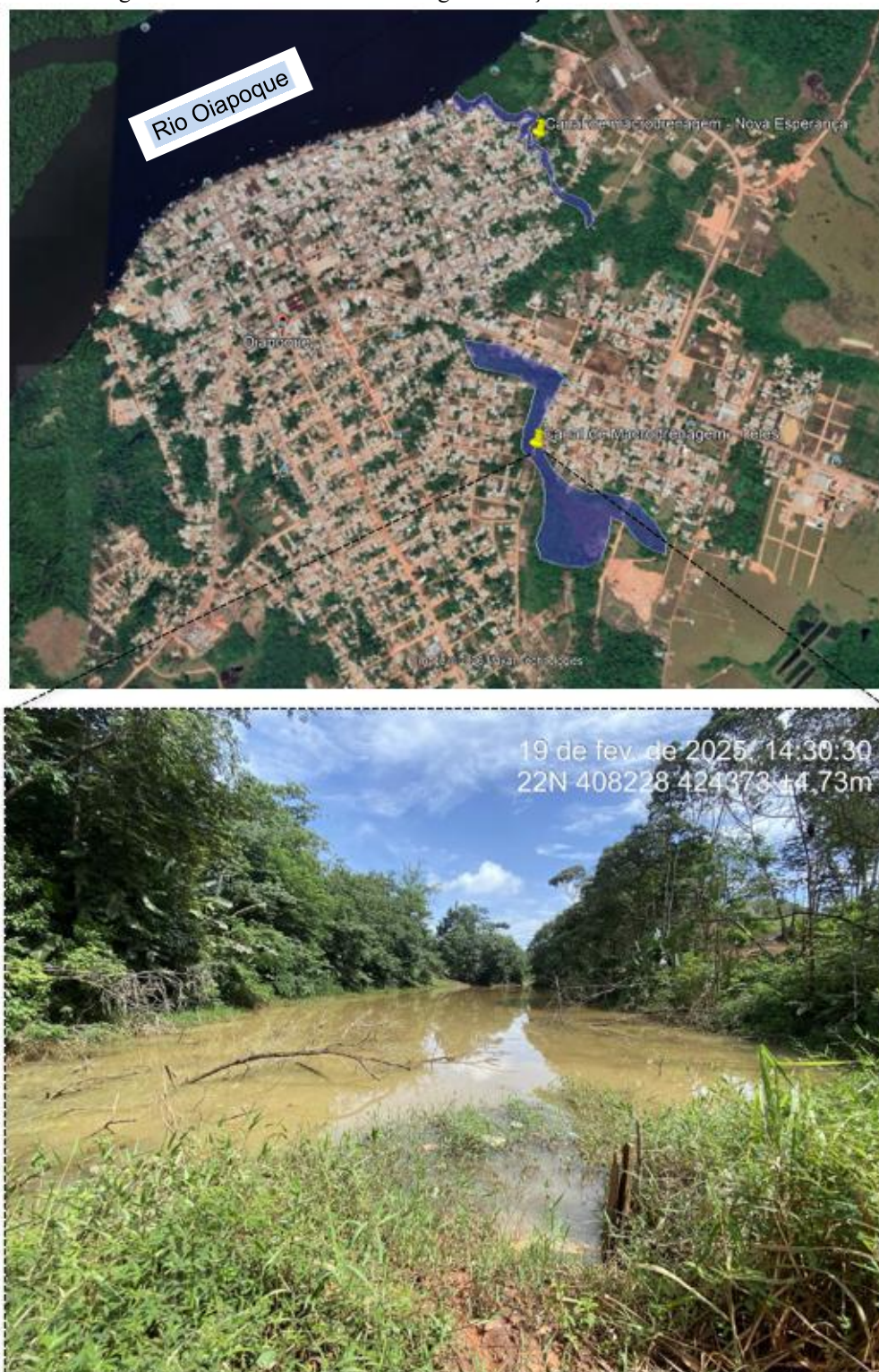
Fotografia 6.1: Canais de Macrodrenagem - Porção Central da área urbanizada
