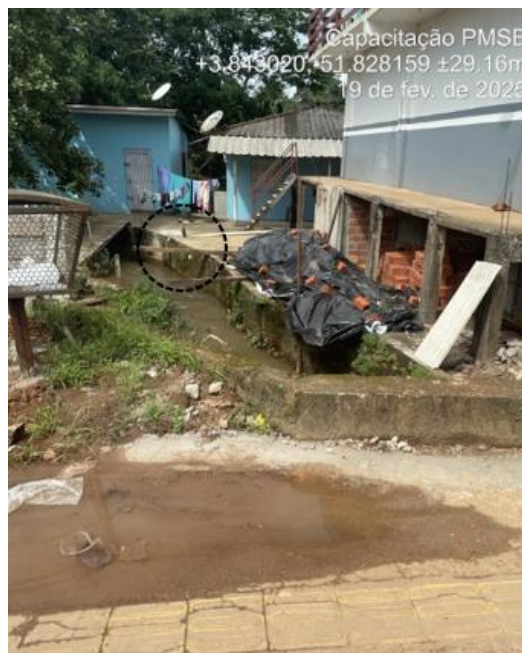
b) Dispositivo de drenagem com ligação clandestina de esgoto
