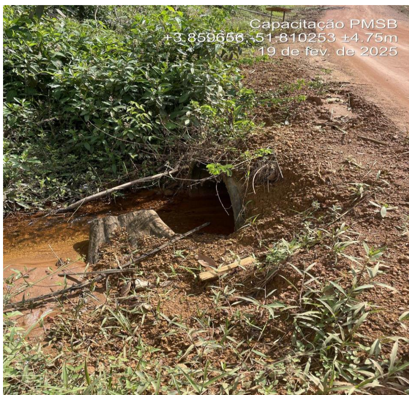
Fotografia 5.3: Terreno contendo lançamento de esgoto em via pública (registro durante o período chuvoso)
