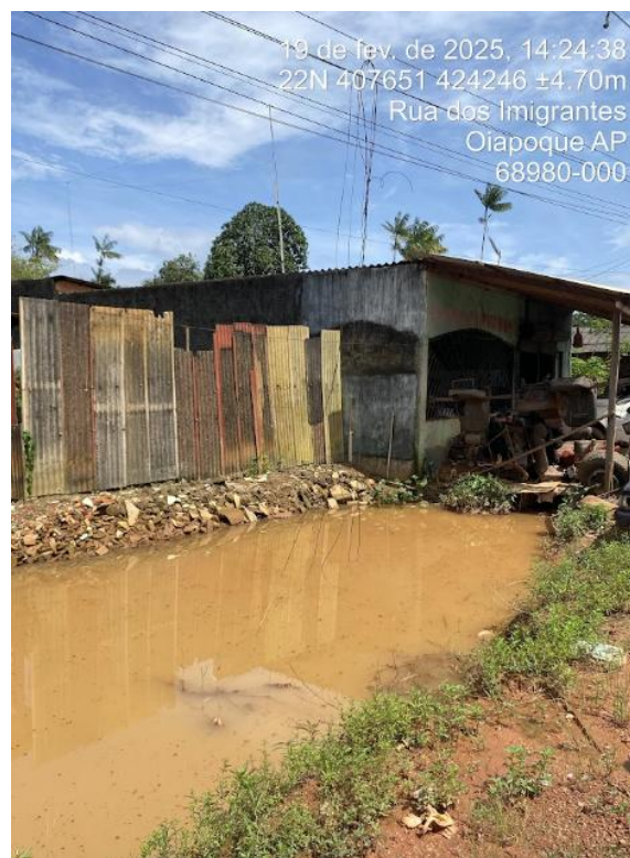
d) Registro de escoamento em canaleta (cava de drenagem) sem revestimento.
