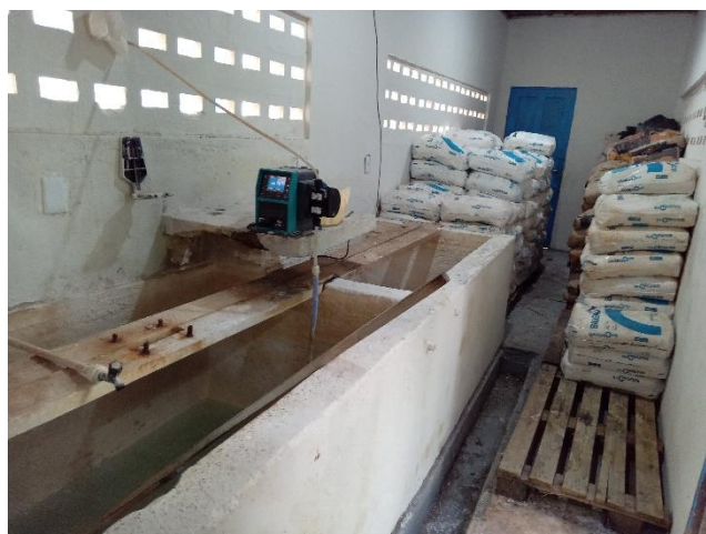
Fotografia 4.9: Sistema de cloração manual
