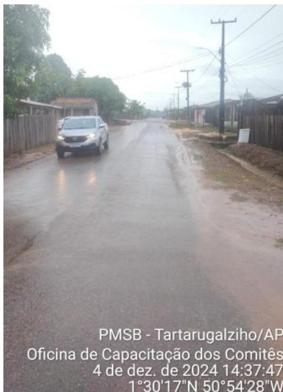
c) Registro de vias sem sistema de meio fio/sarjeta.
