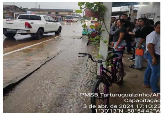
f) Ausência de faixa permeável entre o passeio público e a edificação e/ou falta de conexão entre a cobertura e a drenagem pluvial da via. (Centro)
