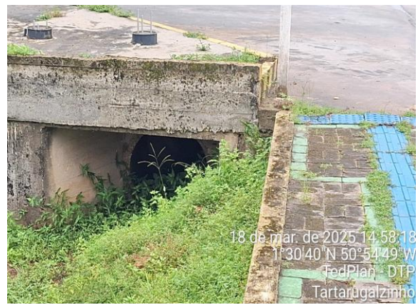
f) Galeria de saída (bairro centro, parte norte)
