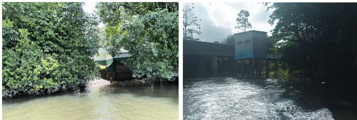
a) Adjacências da captação de água da AMCEL - b) Estação de tratamento municipal - jusante montante
