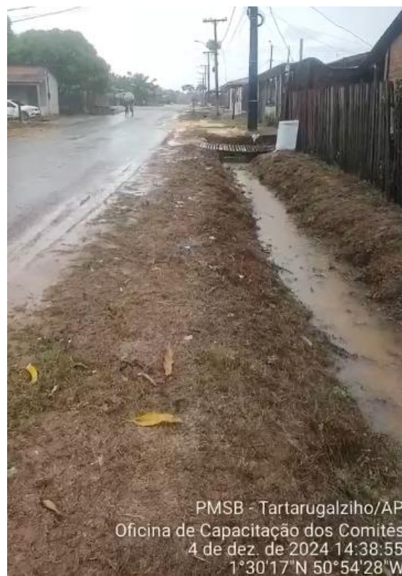
d) Registro de escoamento em canaleta (cava de drenagem) sem revestimento.
