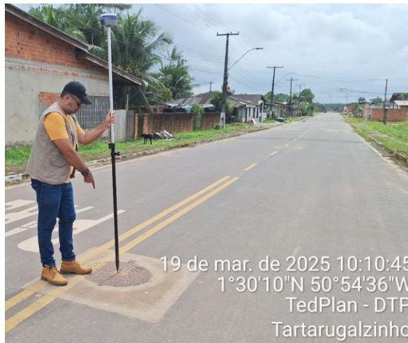
a) Georreferenciamento de Poço de Visita existente (PV)
