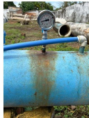
e) Ponto de injeção do sulfato de alumínio (dispensor)
