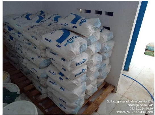
d) Armazenamento do sulfato granulado de alumínio 17% e Hipoclorito de Cálcio - compartimento de química
