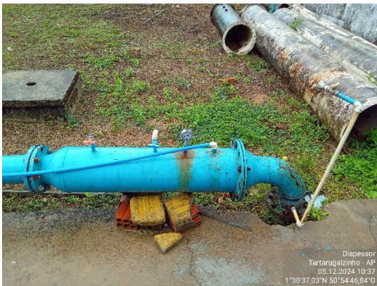
e) Ponto de injeção do sulfato de alumínio (dispensor)
