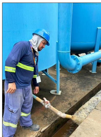
b) Descarte do lodo através de vala
