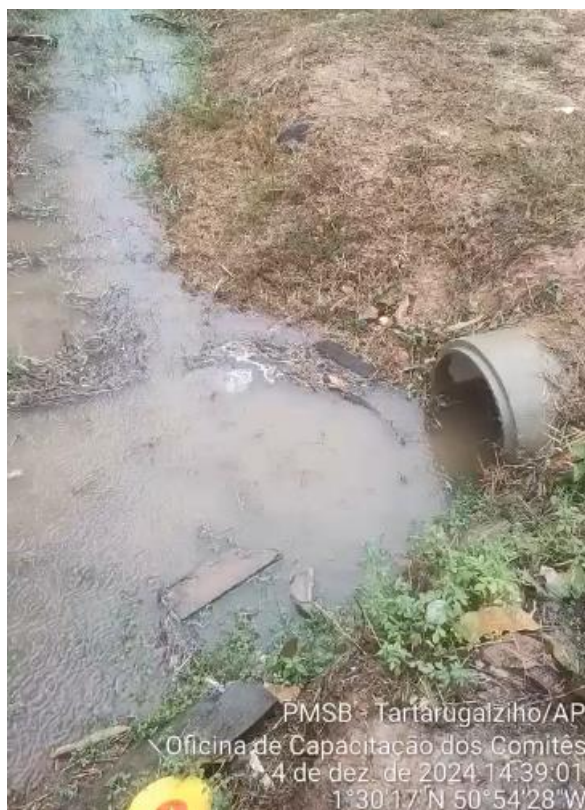
a) Galeria de travessia de rua não pavimentada
