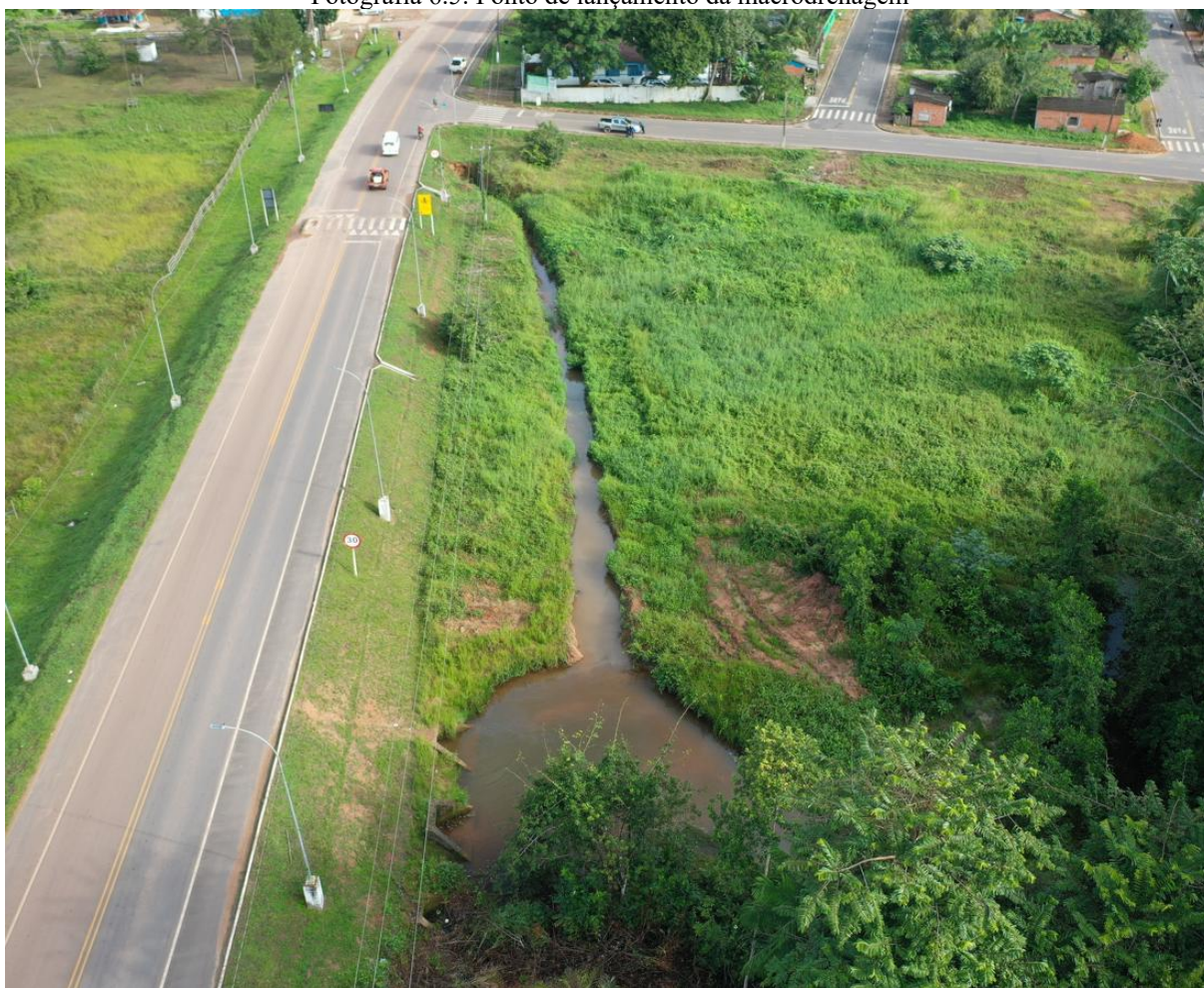
Fotografia 6.5: Ponto de lançamento da macrodrenagem
