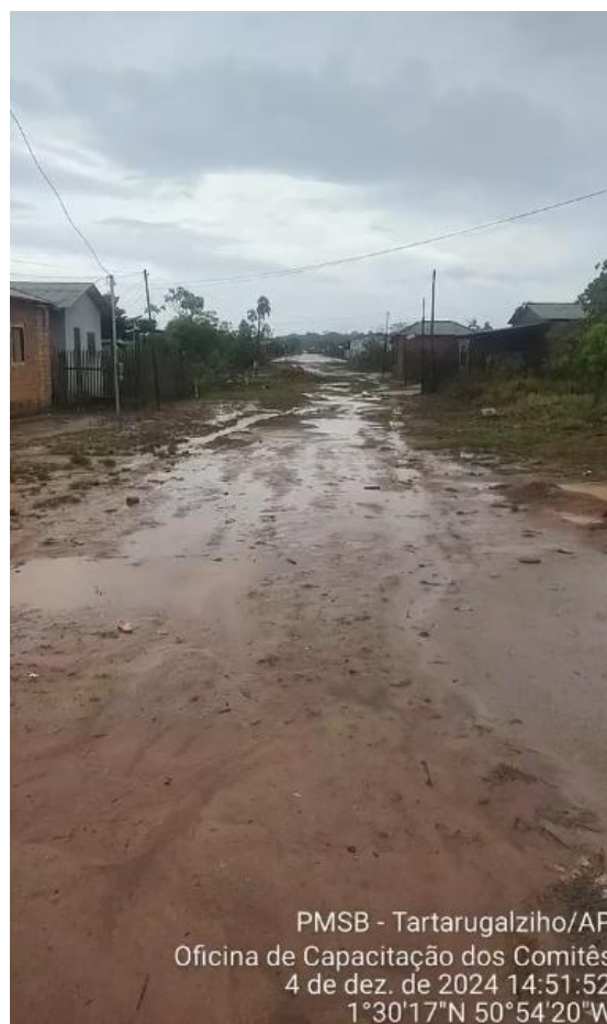
b) Registro de via com ausência de pavimentação e consequentemente sem dispositivos de drenagem.
