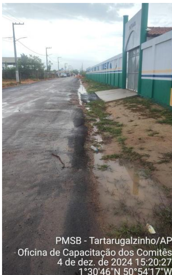
a) Drenagem superficial ocorrendo naturalmente, mesmo com ausência de sarjetas.
