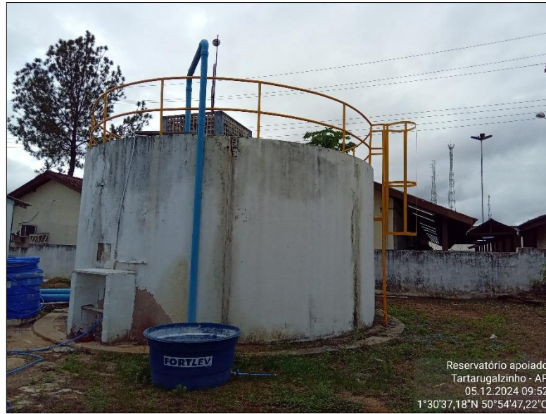
Fotografia 4.7: Reservatório apoiado de 300 mil L
