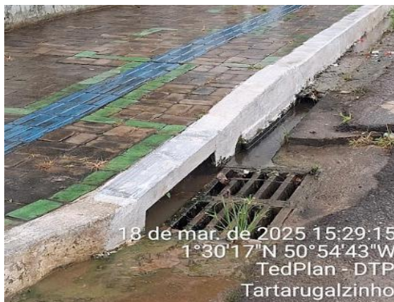
e) Boca do lobo nas proximidades da sede da polícia militar (bairro Centro)
