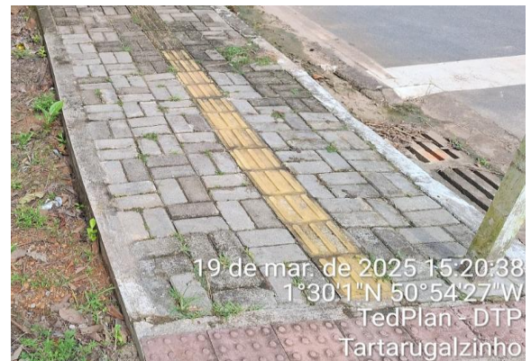
d) Registro de dispositivo de drenagem do tipo boca de lobo com boas condições de uso.
