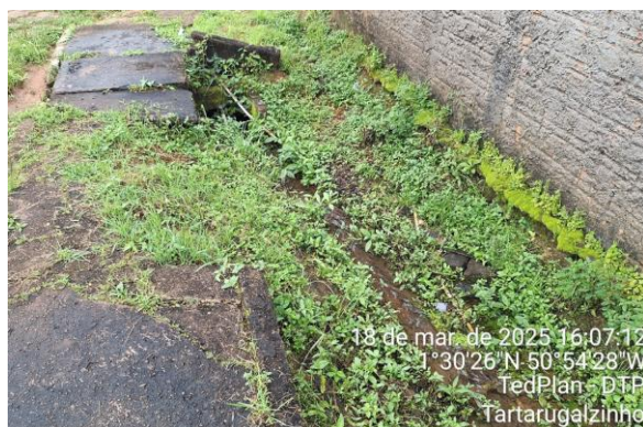
e) Caixa de passagem com tampa danificada
