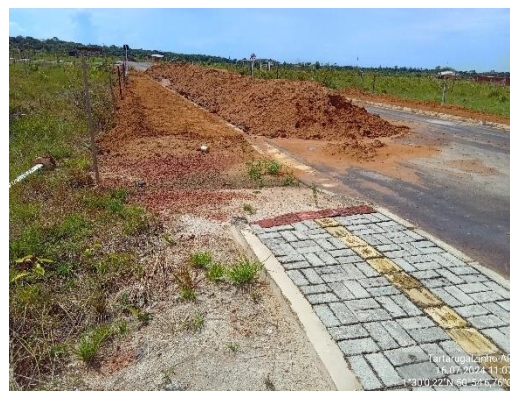
p) Obras de pavimentação e calçamento
