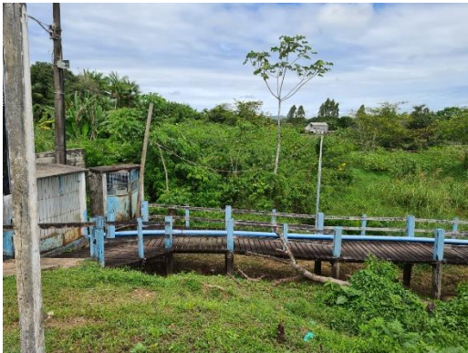
c) Acesso à captação
