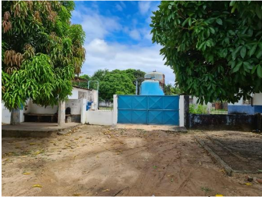
a) Estação de Tratamento de Água
