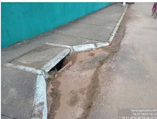
m) Pontos de drenagem
