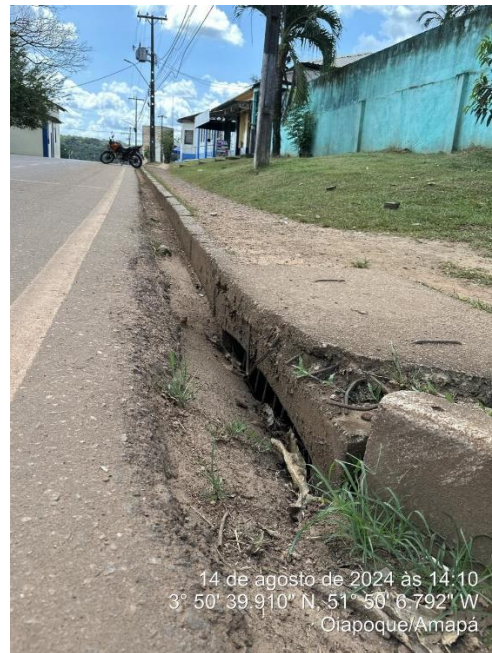
l) Situação da rede de drenagem
