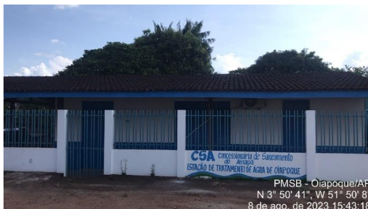
a) Estação Compacta de Tratamento de Água
