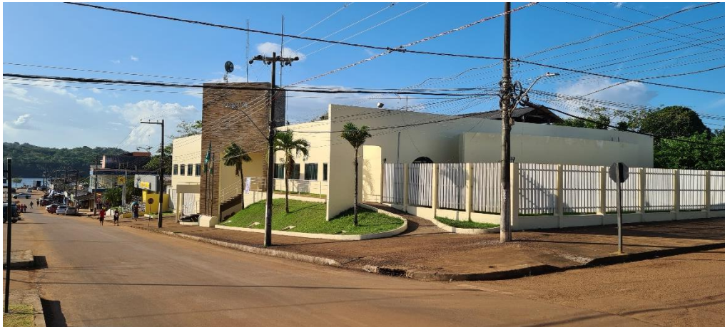
d) Aspectos urbanos do centro da Cidade de Oiapoque, pavimentação, sistemas de microdrenagem – 08 de Agosto de 2023
