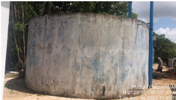
k) Reservatório semienterrado - ETA
